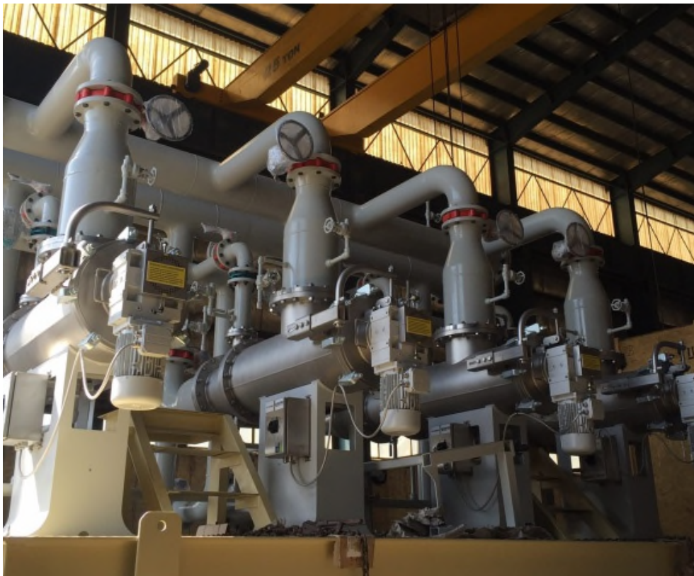
Abbildung 3: Mehrfachinstallation Lenzing OptiFil®
