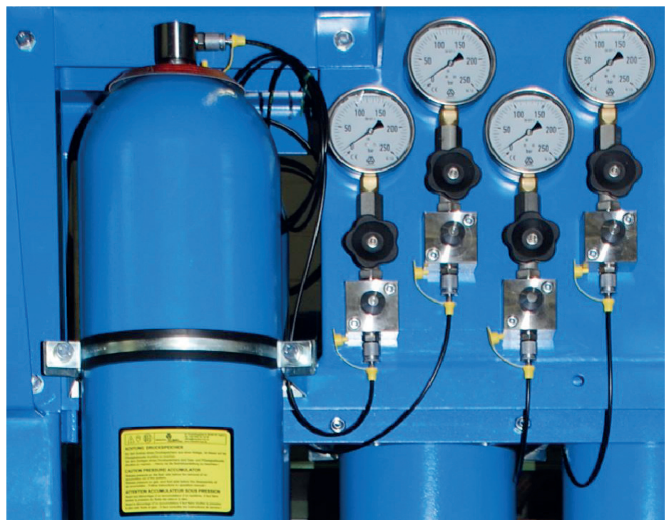
Membranspeicher mit Minimesanschluss bzw 1/4" IG Diaphragm accumulator with mini-measuring connection
