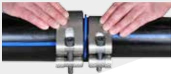
Schellen bündig mit den Rohrenden positionieren.
