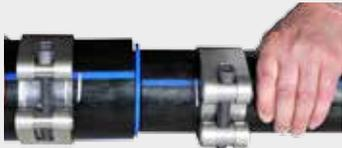
Zweites Rohr bis zum Anschlag auf die Reduktion schieben.
