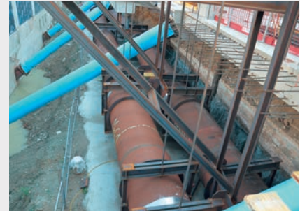
Temporäre Umleitung des Abwasserkanals mit Straub Rohrkupplungen
