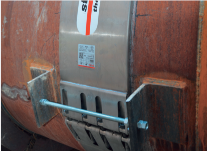
Detailansicht Rohrverbindung Straub-Open-Flex
