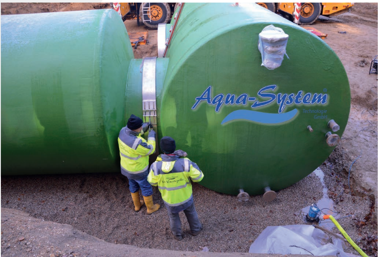
Die Montage der Rohrkupplungen, Foto: Aqua-System GmbH
