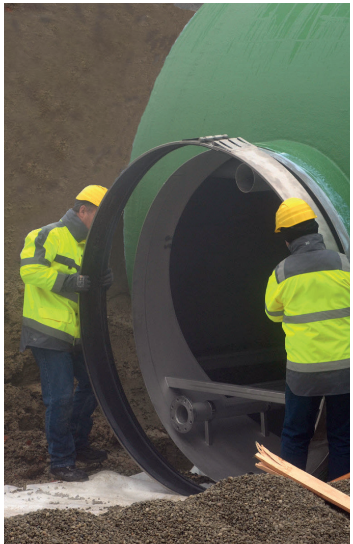
Straub-Rohrkupplungen zeichnen sich durch eine unkomplizierte Montage aus. Foto: HENNLICH
