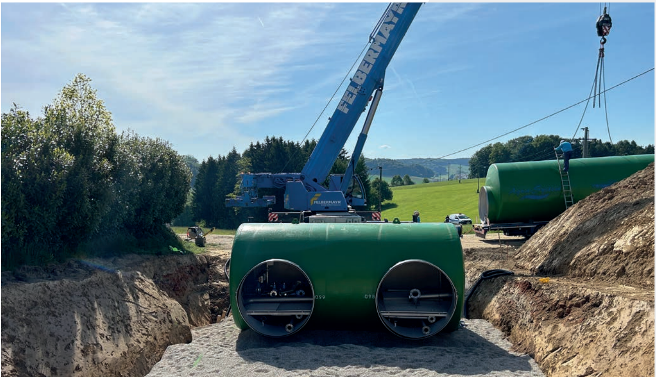
Der Trinkwasserspeicher in der Bauphase, Foto: HENNLICH
