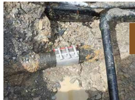
Schadstelle an einer Rohrleitung; schnell und sicher abgedichtet mit STRAUB-REP-FLEX.
