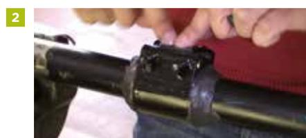
1. Kupplung reinigen und entfetten. Auf beiden Kupplungsseiten eine Markierung im Abstand von 10 cm anzeichnen. Innerhalb der beiden Markierungen Primer aufbringen.
