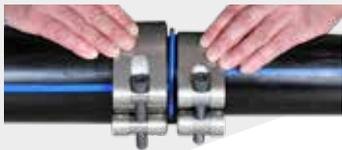
Schellen bündig mit den Rohrenden positionieren.
