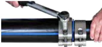
Schrauben mit dem Drehmomentschlüssel auf das angegebene Anzugsmoment anziehen. Wechselseitiges Wiederholen des Anziehprozesses, bis alle Schrauben innerhalb einer Viertelumdrehung (90°) das angegebene Drehmoment erreichen.
