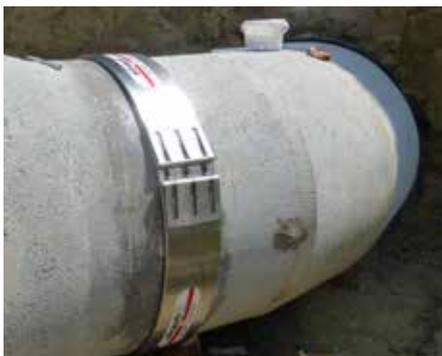
STRAUB-FLEX Rohrkupplungen erlauben Rohrverbindungen für praktisch alle denkbaren Rohrdurchmesser, für gleiche oder unterschiedliche Rohrmaterialien, verschiedenste Medien und Temperaturen sowie für eine grosse Bandbreite der Betriebsdruckwerte.
