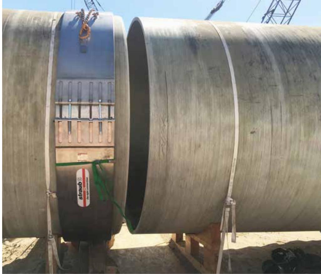
Bändeinlagen einsetzen bei: grossen Rohrendenabständen, Gummi-Quellung, Vakuum, äusserem Überdruck, hohen Temperaturen. Bändeinlagen sind Sonderzubehör und müssen separat bestellt werden.
