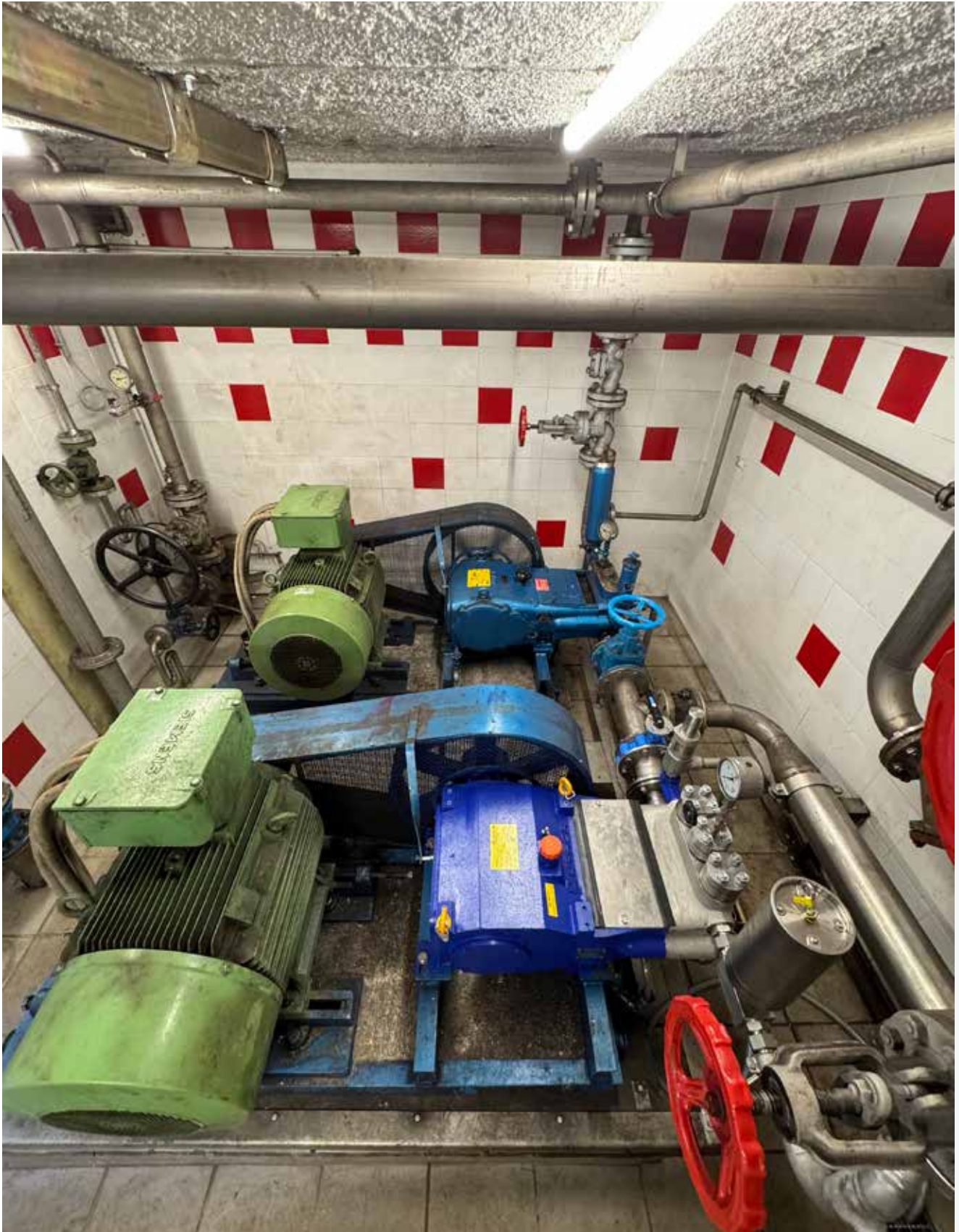
Abb. 2: Aufgrund der ähnlichen Abmessungen der neuen Pumpe konnte der Einbau problemlos erfolgen. (Foto: Gemeinde Hinterstoder)
