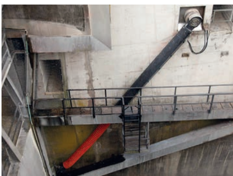
Durch Faltenbalg geschützte Kolbenstange
