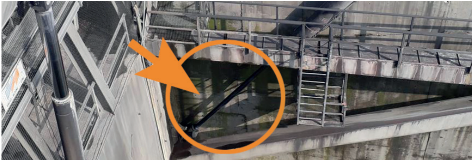
Ungeschützte Zylinderstangen der Wehrzylinder
